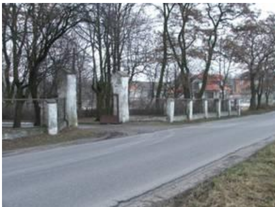
14. Brama wjazdowa i ogrodzenie zespołu dworsko-parkowego w Szynczycach przed remontem przeprowadzonym w 2009 roku
