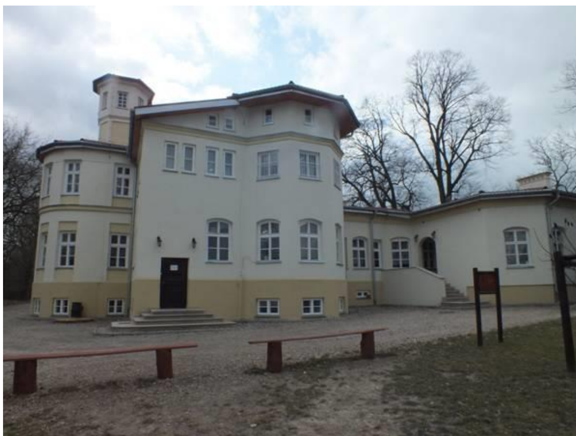
11. Elewacja północno-wschodnia dworu w Szynczycach
