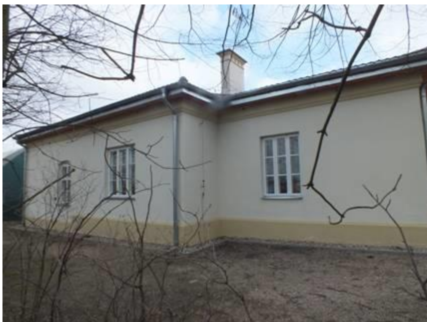
12. Elewacja północno-zachodnia dworu w Szynszycach
