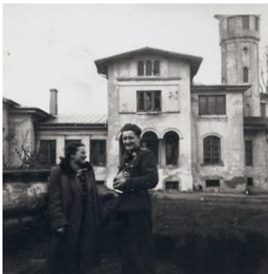
5. Widok elewacji frontowej dworu w Szynclach ok. 1949 roku
