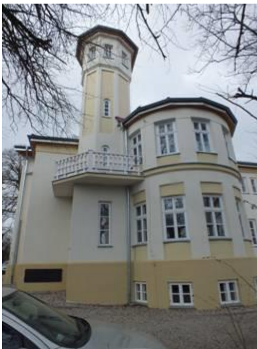
9. Widok elewacji południowo-wschodniej dworu w Szynszycach – część południowa i środkowa
